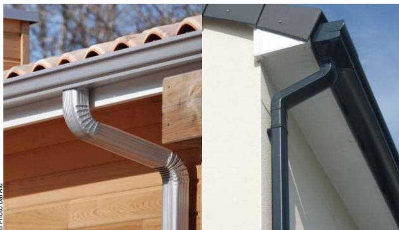
Les gouttières en aluminium peuvent être directement profilées aux dimensions du bâtiment. Sans raccord, elles favorisent une étanchéité maximale.
