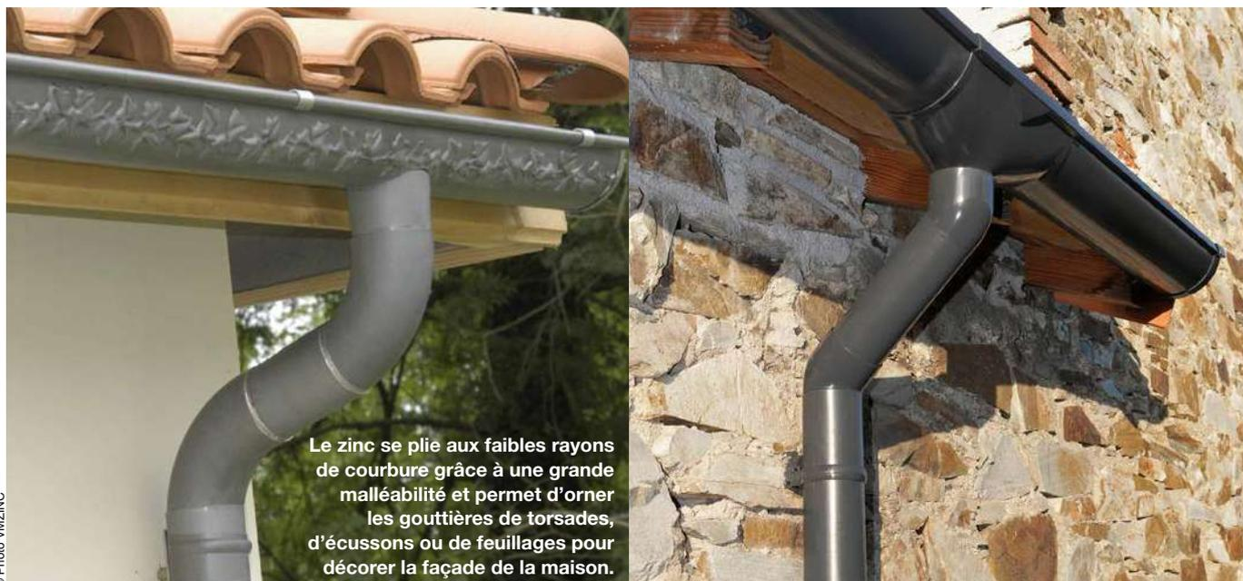
Le zinc se plie aux faibles rayons de courbure grâce à une grande malléabilité et permet d'orner les gouttières de torsades, d'écussons ou de feuillages pour décorer la façade de la maison.
