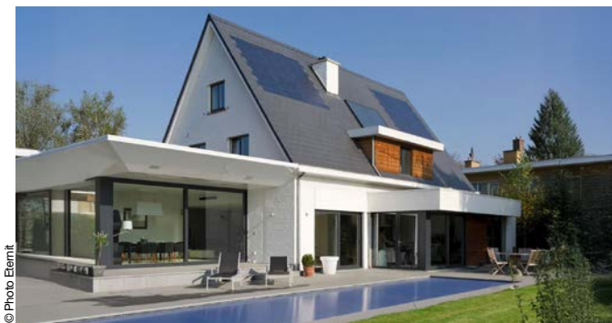
Ce système de tuiles solaires s'intègre parfaitement aux tuiles en ardoise grâce à la similitude de forme, la couleur anthracite et la fine épaisseur.
